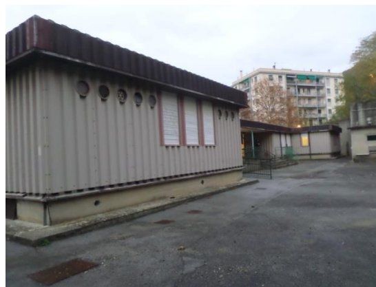
Figura 1.1 - Vista della facciata esposta ad Est
