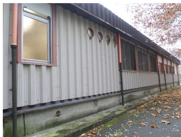
Figura 4.2 - Particolare della facciata est
