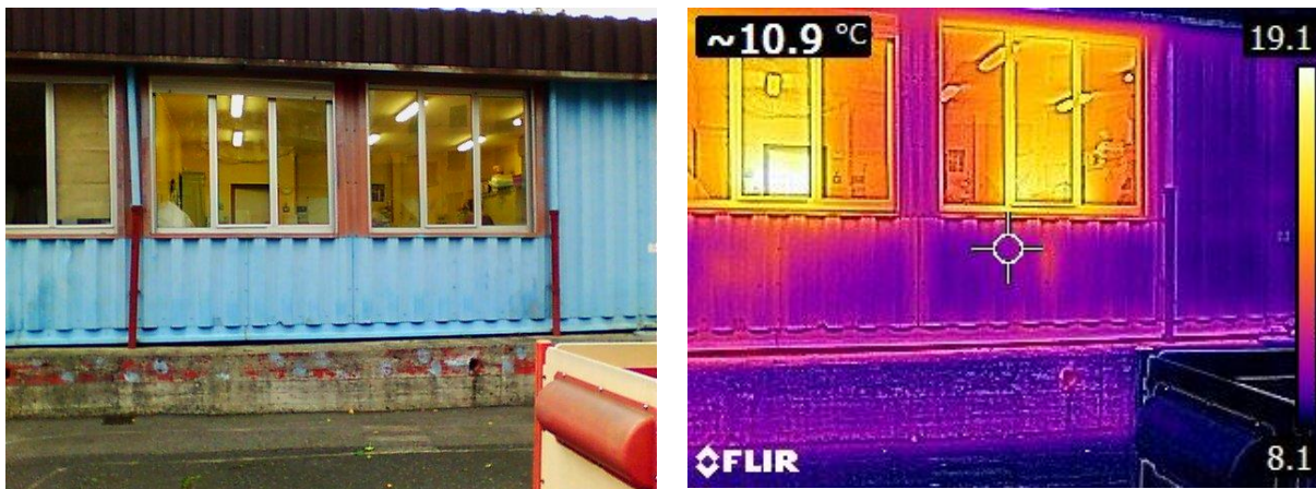
Figura 4.5 –Rilievo termografico dei serramenti
